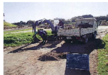
越流後の堆積土の除去作業
